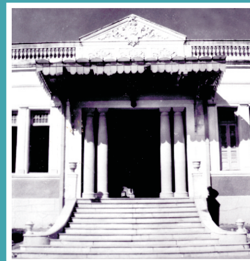
Fachada frontal da Fundação Cultural Calmon Barreto, antiga Estação Ferroviária. Vê-se em primeiro plano a escada de acesso à entrada principal do prédio. Abril de 1991. AF/FCCB/0749.
